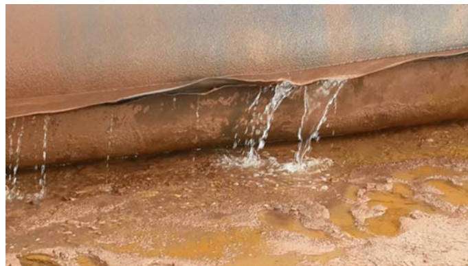
Figura 6 - Saída da água totalmente limpa, sem finos
